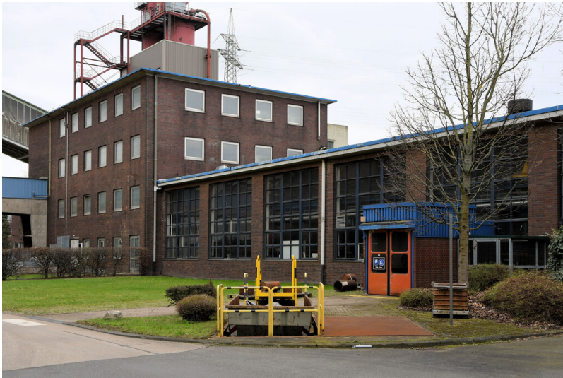
Kraftwerk Frimmersdorf II: Lager / Werkstatt I, Ansicht von Nordwesten; Foto: 22.03.2023 Fotograf/Urheber: Dr. Norbert Gilson
