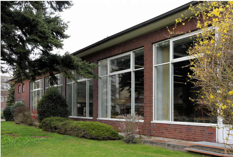
Kraftwerk Frimmersdorf II: Kantine, Ansicht von Südwesten; Foto: 22.03.2023 Fotograf/Urheber: Dr. Norbert Gilson
