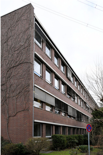
Kraftwerk Frimmersdorf II: Verwaltungsgebäude, südlicher Erweiterungsbau, Ansicht von Südosten; Foto: 22.03.2023 Fotograf/Urheber: Dr. Norbert Gilson
