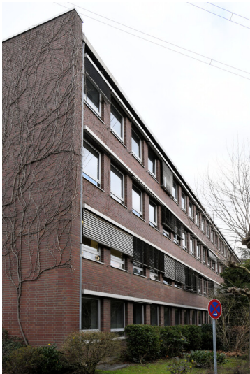
Kraftwerk Frimmersdorf II: Verwaltungsgebäude, südlicher Erweiterungsbau, Ansicht von Südosten; Foto: 22.03.2023 Fotograf/Urheber: Dr. Norbert Gilson
