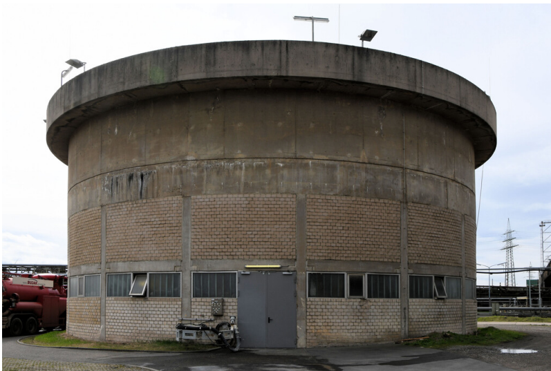
Kraftwerk Frimmersdorf II: Abwasserentsorgung, Schlammeindicker, Ansicht von Norden; Foto: 22.03.2023 Fotograf/Urheber: Dr. Norbert Gilson
