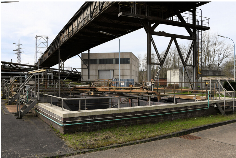
Kraftwerk Frimmersdorf II: Abwasserentsorgung, Belebungsbecken, Ansicht von Nordosten; Foto: 22.03.2023 Fotograf/Urheber: Dr. Norbert Gilson
