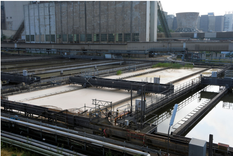
Kraftwerk Frimmersdorf II: Aschewasser-Klärbecken, Kammer 3, Ansicht von Westen; Foto: 23.06.2023 Fotograf/Urheber: Dr. Norbert Gilson
