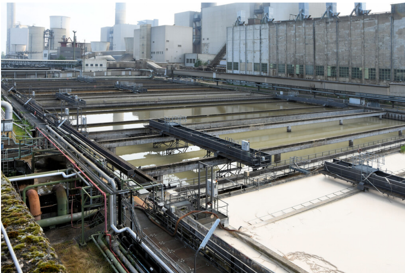
Kraftwerk Frimmersdorf II: Rohwasser-Klärbecken, im Bild links, hinter den Kammern des Betriebswasser-Klärbeckens (Bildmitte) gelegen, Ansicht von Südwesten; Foto: 23.06.2023 Fotograf/Urheber: Dr. Norbert Gilson
