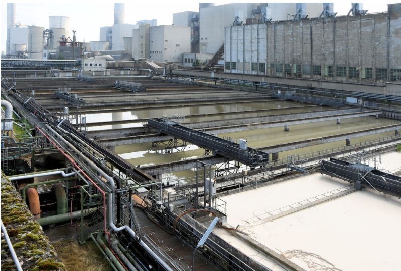
Kraftwerk Frimmersdorf II: Betriebswasser-Klärbecken mit drei Kammern (Bildmitte), Ansicht von Westen; Foto: 23.06.2023 Fotograf/Urheber: Dr. Norbert Gilson
