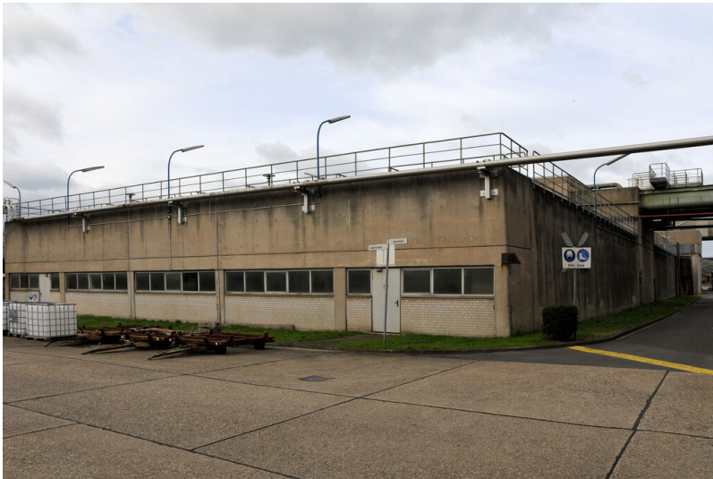
Kraftwerk Frimmersdorf II: Wasseraufbereitung, Pulsatoranlage, Ansicht von Osten; Foto: 22.03.2023 Fotograf/Urheber: Dr. Norbert Gilson
