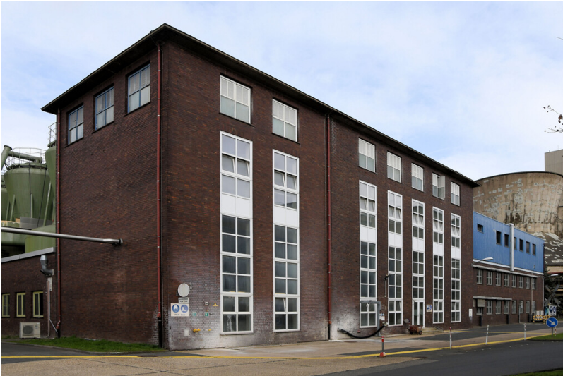
Kraftwerk Frimmersdorf II: Wasseraufbereitung, Kopfbau des Silotraktes, Ansicht von Südosten; Foto: 22.03.2023 Fotograf/Urheber: Dr. Norbert Gilson
