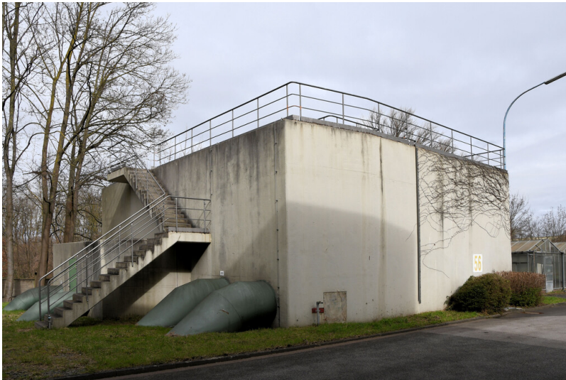
Kraftwerk Frimmersdorf II: Mischwerk für die Mischung von Tagebau-Sümpfungswässern und Erftwasser, Ansicht von Süden; Foto: 22.03.2023 Fotograf/Urheber: Dr. Norbert Gilson
