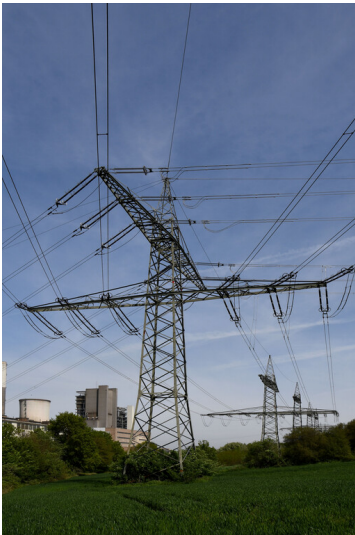
Kraftwerk Frimmersdorf II: Abspannmast 32B (im Vordergrund) sowie 32C, 32D und 32E (im Hintergrund), Ansicht von Süden; Foto: 04.05.2023 Fotograf/Urheber: Dr. Norbert Gilson
