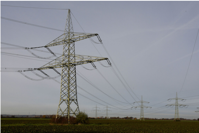
Kraftwerk Frimmersdorf II: Abspannmast 1 der Leitung Bl-Nr. 4535 an der Umspannanlage Rommerskirchen, jetzt Einführung der 380-kV-Leitung von Block F/G Kraftwerk Neurath (linke Traverse) sowie einer weiteren Leitung (rechte Traverse), Ansicht von Norden; Foto: 22.11.2023 Fotograf/Urheber: Dr. Norbert Gilson
