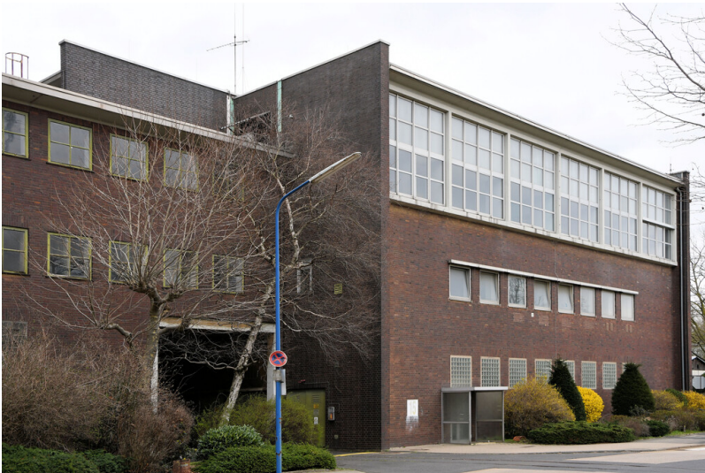
Kraftwerk Frimmersdorf II: E-Warte (rechts) und Zentralwarte (links), Ansicht von Südwesten; Foto: 21.03.2023 Fotograf/Urheber: Dr. Norbert Gilson
