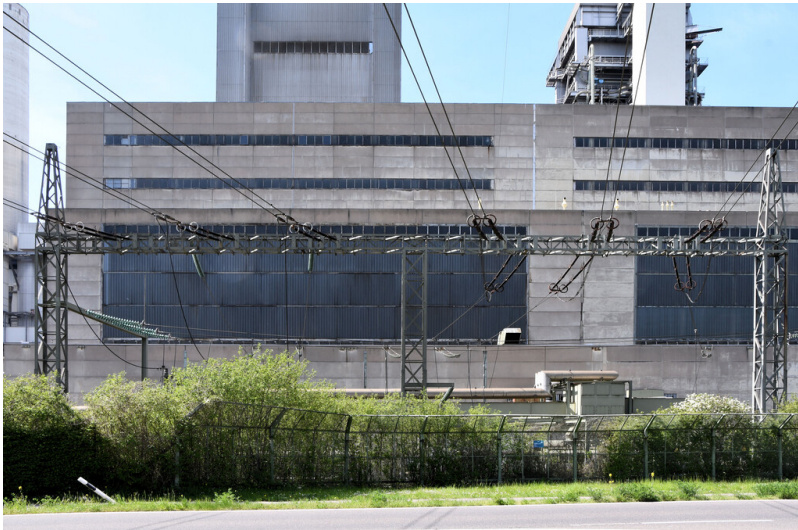
Kraftwerk Frimmersdorf II: Freileitungsabgangsfelder Block P (links) und Block Q (rechts), Ansicht von Osten; Foto: 04.05.2023 Fotograf/Urheber: Dr. Norbert Gilson
