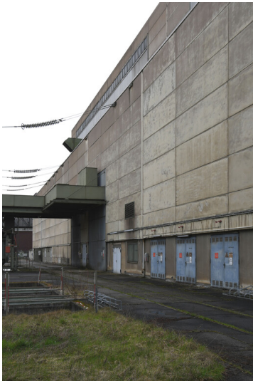
Kraftwerk Frimmersdorf II: Schaltanlagenvorbau Block Q, Ansicht von Nordosten; Foto: 21.03.2023 Fotograf/Urheber: Dr. Norbert Gilson
