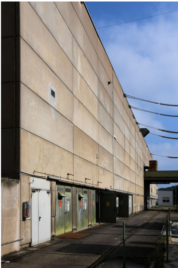
Kraftwerk Frimmersdorf II: Schaltanlagenvorbau Block P, Ansicht von Südosten; Foto: 23.06.2023 Fotograf/Urheber: Dr. Norbert Gilson
