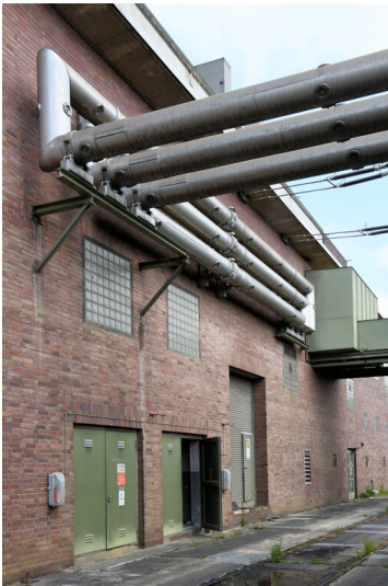
Kraftwerk Frimmersdorf II: Schaltanlagenvorbau Block N, Ansicht von Südosten; Foto: 23.06.2023 Fotograf/Urheber: Dr. Norbert Gilson
