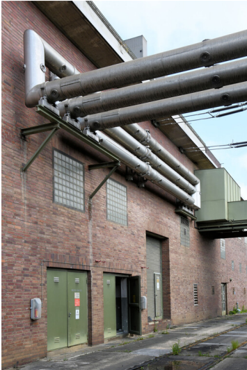
Kraftwerk Frimmersdorf II: Schaltanlagenvorbau Block N, Ansicht von Südosten; Foto: 23.06.2023 Fotograf/Urheber: Dr. Norbert Gilson
