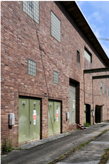
Kraftwerk Frimmersdorf II: Schaltanlagenvorbau Block K, Ansicht von Südosten; Foto: 23.06.2023 Fotograf/Urheber: Dr. Norbert Gilson
