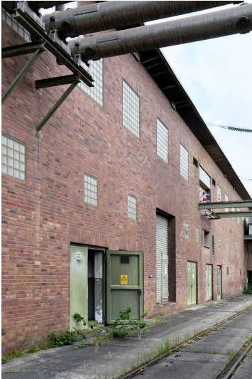
Kraftwerk Frimmersdorf II: Schaltanlagenvorbau Block H, Ansicht von Südosten; Foto: 23.06.2023 Fotograf/Urheber: Dr. Norbert Gilson
