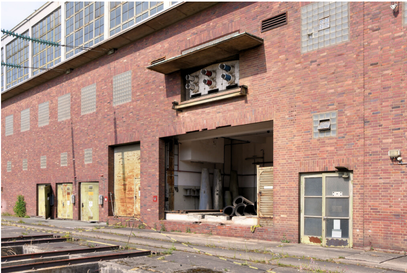
Kraftwerk Frimmersdorf II: Schaltanlagenvorbau Block C, Ansicht von Nordosten; Foto: 23.06.2023 Fotograf/Urheber: Dr. Norbert Gilson
