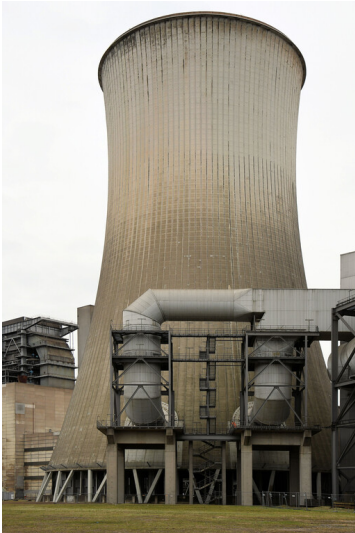
Kraftwerk Frimmersdorf II: Naturzug-Kühlturm von Block Q, Ansicht von Nordwesten; Foto: 22.03.2023 Fotograf/Urheber: Dr. Norbert Gilson
