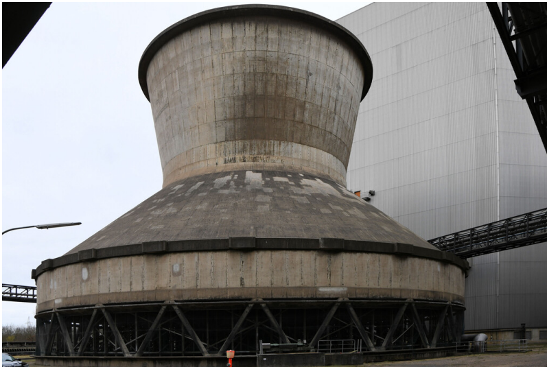
Kraftwerk Frimmersdorf II: Ventilator-Kühlturm P3, Ansicht von Nordwesten; Foto: 22.03.2023 Fotograf/Urheber: Dr. Norbert Gilson
