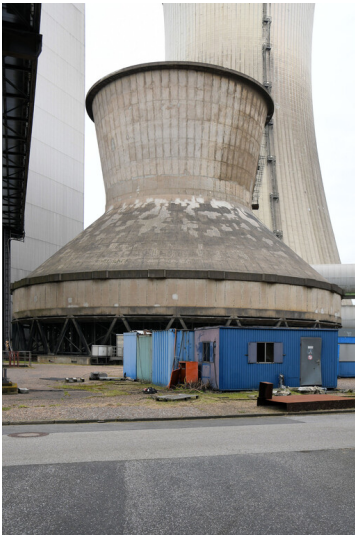
Kraftwerk Frimmersdorf II: Ventilator-Kühlturm P2, Ansicht von Süden; Foto: 22.03.2023 Fotograf/Urheber: Dr. Norbert Gilson
