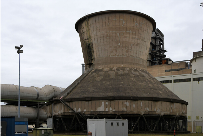
Kraftwerk Frimmersdorf II: Ventilator-Kühlturm P1, Ansicht von Südwesten; Foto: 22.03.2023 Fotograf/Urheber: Dr. Norbert Gilson
