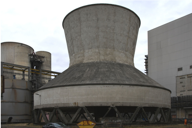
Kraftwerk Frimmersdorf II: Ventilator-Kühlturm 27, Ansicht von Westen; Foto: 22.03.2023 Fotograf/Urheber: Dr. Norbert Gilson
