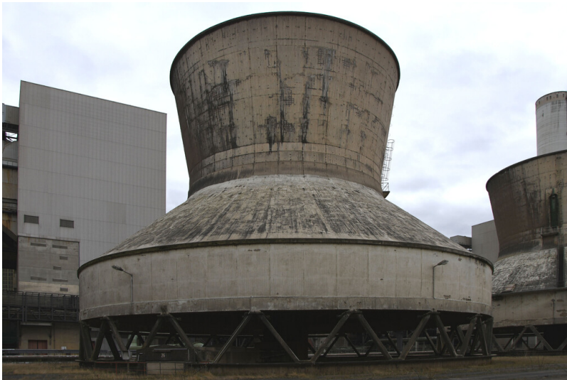
Kraftwerk Frimmersdorf II: Ventilator-Kühlturm 26, Ansicht von Westen; Foto: 22.03.2023 Fotograf/Urheber: Dr. Norbert Gilson
