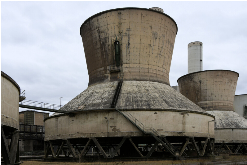
Kraftwerk Frimmersdorf II: Ventilator-Kühlturm 26, Ansicht von Nordwesten; Foto: 22.03.2023 Fotograf/Urheber: Dr. Norbert Gilson
