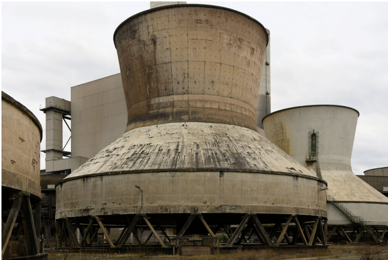
Kraftwerk Frimmersdorf II: Ventilator-Kühlturm 24, Ansicht von Nordwesten; Foto: 22.03.2023 Fotograf/Urheber: Dr. Norbert Gilson
