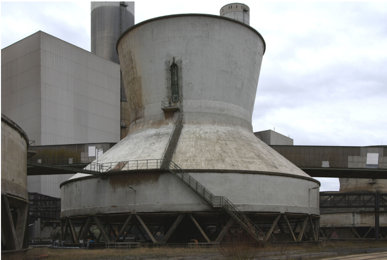
Kraftwerk Frimmersdorf II: Ventilator-Kühlturm 23, Ansicht von Nordwesten; Foto: 22.03.2023 Fotograf/Urheber: Dr. Norbert Gilson
