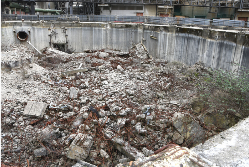
Kraftwerk Frimmersdorf II: Ventilator-Kühlturmtonne 22, Stahlbetonreste des ehemaligen Kühlturmbaus, Ansicht von Westen; Foto: 22.03.2023 Fotograf/Urheber: Dr. Norbert Gilson
