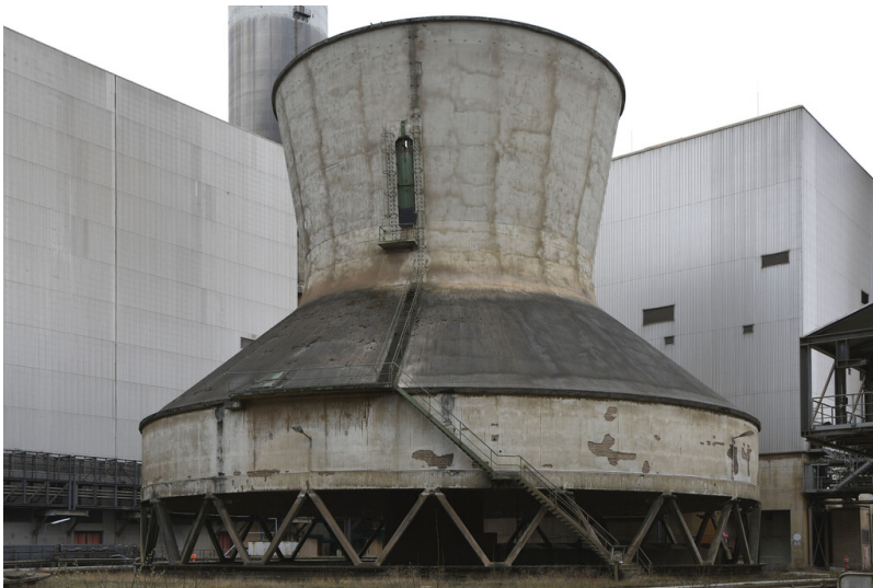
Kraftwerk Frimmersdorf II: Ventilator-Kühlturm 21, Ansicht von Nordwesten; Foto: 22.03.2023 Fotograf/Urheber: Dr. Norbert Gilson
