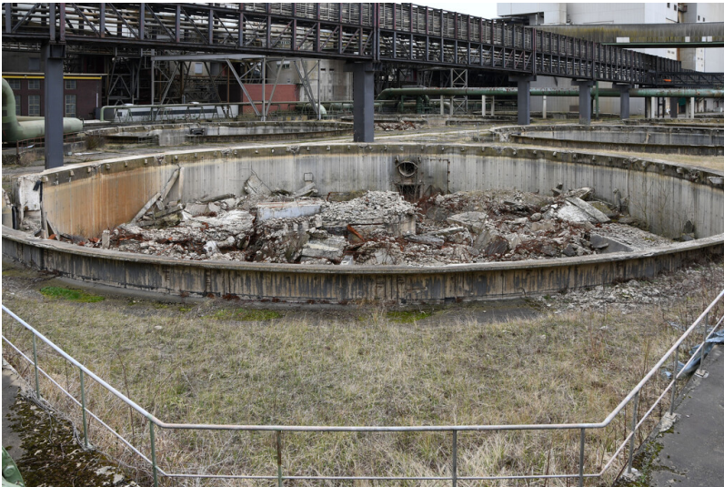
Kraftwerk Frimmersdorf II: Ventilator-Kühlturmtasse 20, Ansicht von Nordwesten; Foto: 22.03.2023 Fotograf/Urheber: Dr. Norbert Gilson
