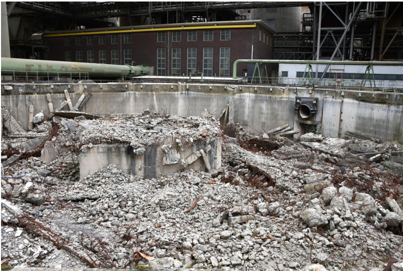
Kraftwerk Frimmersdorf II: Ventilator-Kühlturmtonne 19, Stahlbetonreste des ehemaligen Kühlturmbaus, Ansicht von Westen; Foto: 22.03.2023 Fotograf/Urheber: Dr. Norbert Gilson
