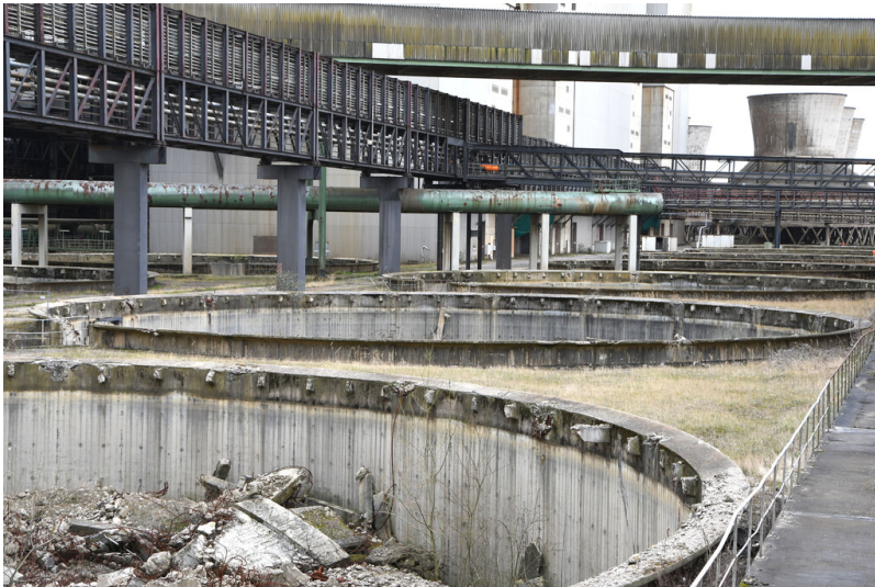
Kraftwerk Frimmersdorf II: Ventilator-Kühlturmtasse 18, Ansicht von Norden; Foto: 22.03.2023 Fotograf/Urheber: Dr. Norbert Gilson
