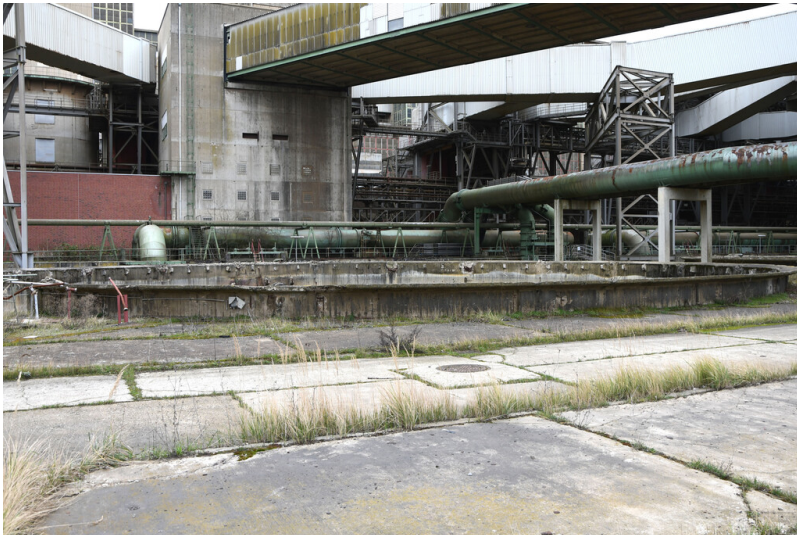
Kraftwerk Frimmersdorf II: Ventilator-Kühlturmtasse 17, Ansicht von Westen; Foto: 22.03.2023 Fotograf/Urheber: Dr. Norbert Gilson
