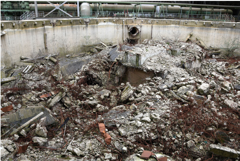
Kraftwerk Frimmersdorf II: Ventilator-Kühlturmtasse 15, Stahlbetonreste des ehemaligen Kühlturmbaus, Ansicht von Südwesten; Foto: 22.03.2023 Fotograf/Urheber: Dr. Norbert Gilson
