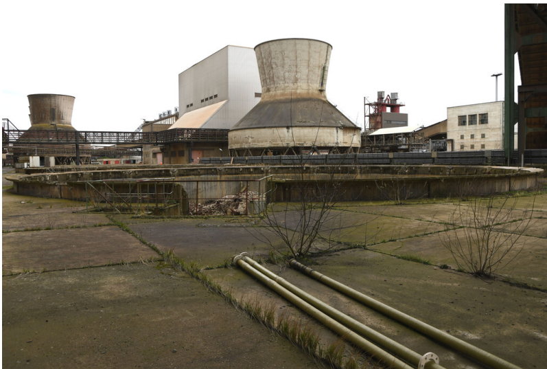
Kraftwerk Frimmersdorf II: Ventilator-Kühlturmtasse 14, Ansicht von Nordosten; Foto: 22.03.2023 Fotograf/Urheber: Dr. Norbert Gilson
