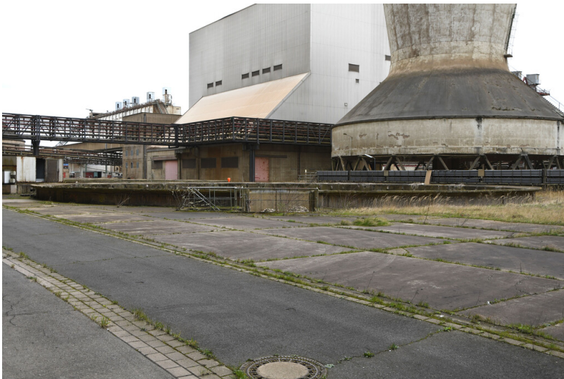
Kraftwerk Frimmersdorf II: Ventilator-Kühlturmtasse 12, Ansicht von Nordosten; Foto: 22.03.2023 Fotograf/Urheber: Dr. Norbert Gilson
