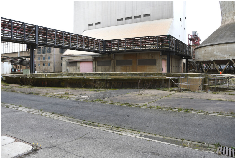
Kraftwerk Frimmersdorf II: Ventilator-Kühlturmtasse 10, Ansicht von Nordosten; Foto: 22.03.2023 Fotograf/Urheber: Dr. Norbert Gilson
