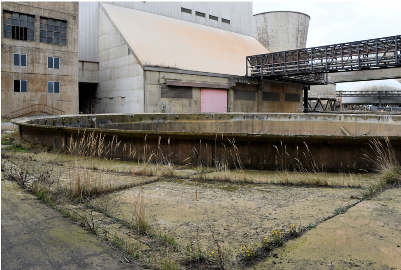
Kraftwerk Frimmersdorf II: Ventilator-Kühlturmtasse 8, Ansicht von Südosten; Foto: 22.03.2023 Fotograf/Urheber: Dr. Norbert Gilson
