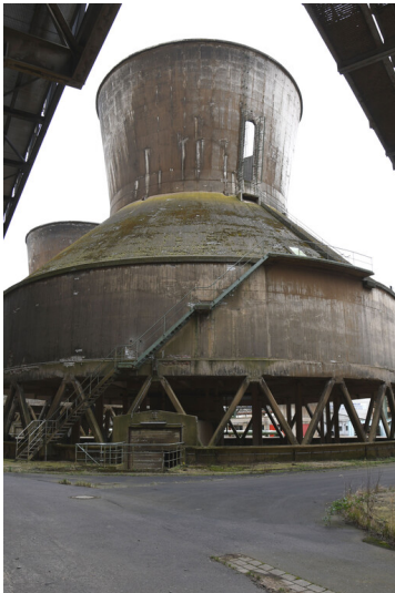
Kraftwerk Frimmersdorf II: Ventilator-Kühlturm 6, Ansicht von Norden; Foto: 22.03.2023 Fotograf/Urheber: Dr. Norbert Gilson
