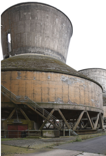
Kraftwerk Frimmersdorf II: Ventilator-Kühlturm 5, Ansicht von Nordwesten; Foto: 22.03.2023 Fotograf/Urheber: Dr. Norbert Gilson
