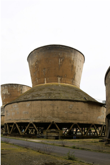
Kraftwerk Frimmersdorf II: Ventilator-Kühlturm 4, Ansicht von Nordosten; Foto: 22.03.2023 Fotograf/Urheber: Dr. Norbert Gilson
