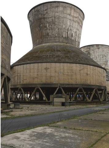
Kraftwerk Frimmersdorf II: Ventilator-Kühlturm 3, Ansicht von Nordwesten; Foto: 22.03.2023 Fotograf/Urheber: Dr. Norbert Gilson
