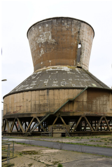
Kraftwerk Frimmersdorf II: Ventilator-Kühlturm 2, Ansicht von Nordosten; Foto: 22.03.2023 Fotograf/Urheber: Dr. Norbert Gilson
