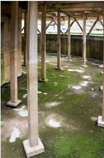
Kraftwerk Frimmersdorf II: Ventilator-Kühlturm 1, Kühlturmeinbauten; Foto: 22.03.2023 Fotograf/Urheber: Dr. Norbert Gilson
