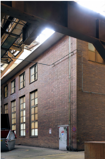
Kraftwerk Frimmersdorf II: Kühlwasser-Pumpenhaus 3, Ansicht von Nordosten; Foto: 21.03.2023 Fotograf/Urheber: Dr. Norbert Gilson
