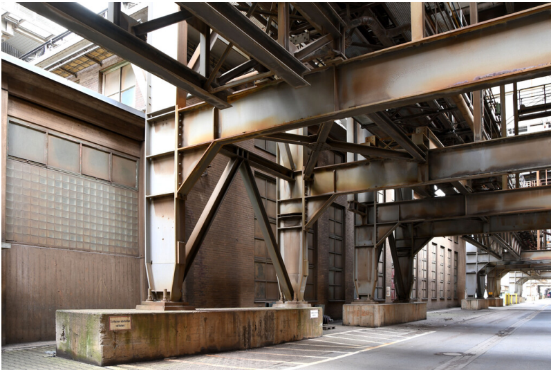
Kraftwerk Frimmersdorf II: Kühlwasser-Pumpenhaus 2, Ansicht von Süden; Foto: 21.03.2023 Fotograf/Urheber: Dr. Norbert Gilson
